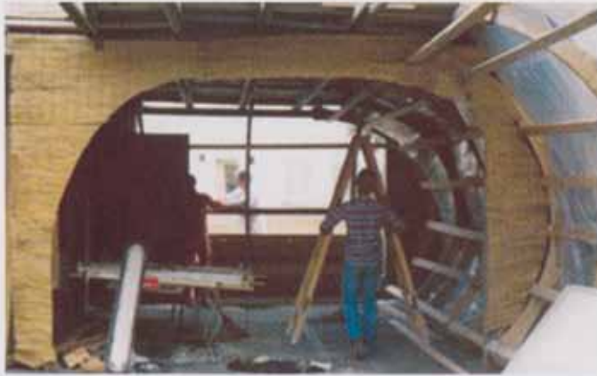
Der Aufbau kurz vor der Fertigstellung...
