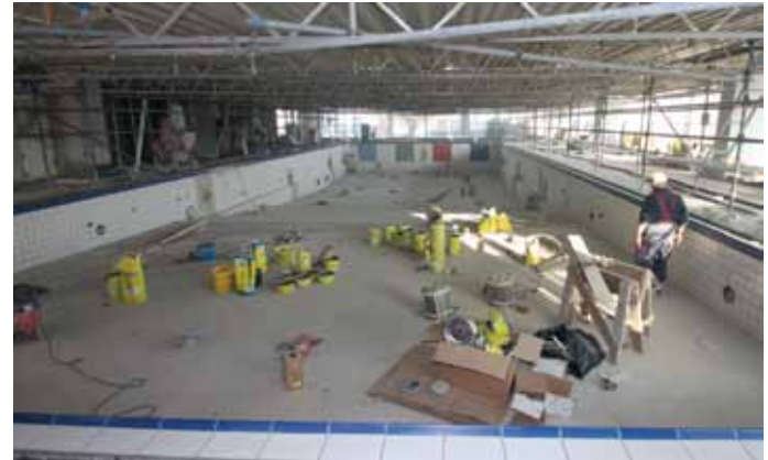
Baustelle am 13. Januar 2013
