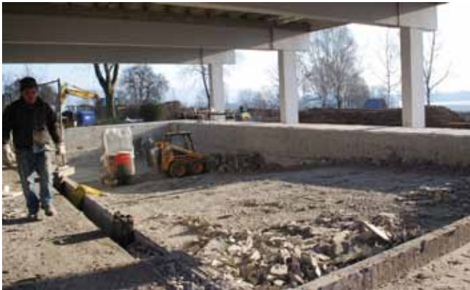
Baustelle am 6. Februar 2012
